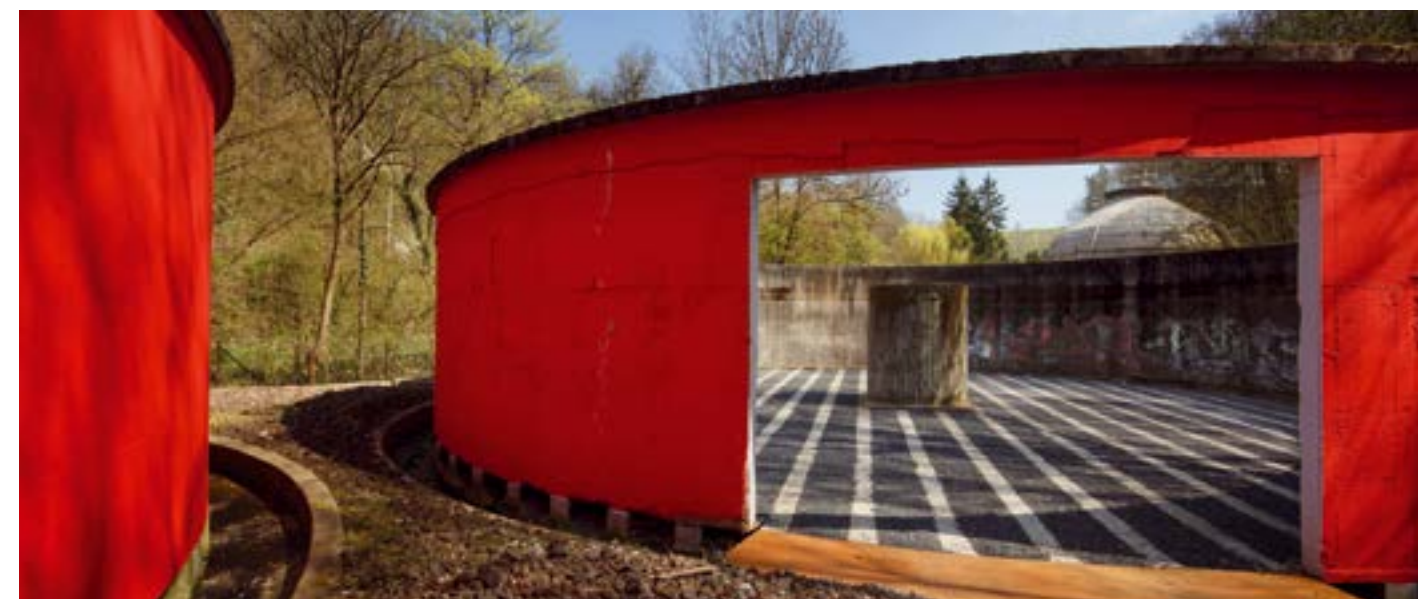
Licht- und Klanginstallationen inszenieren die Tropfkörperbehälter einer ehemaligen Kläranlage in Fellbach
