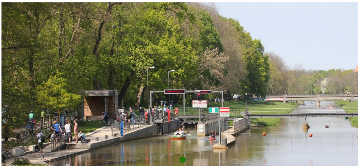
Schleuse Connewitz (Quelle: bgmr)
