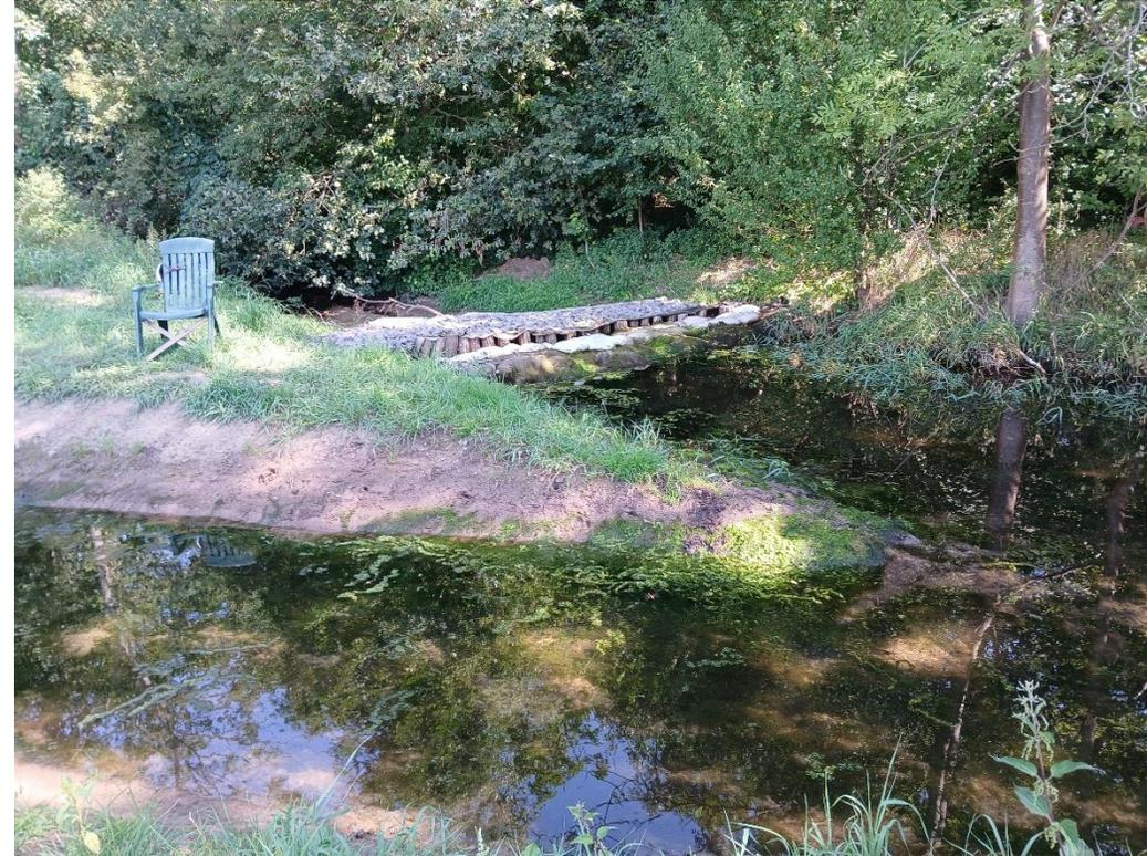
Temporäres Bauwerk seit Juli 2024 zur Umlenkung von Niedrig und Mittelwasser bis Bauabschnitt Zschampert Süd fertiggestellt wird.
