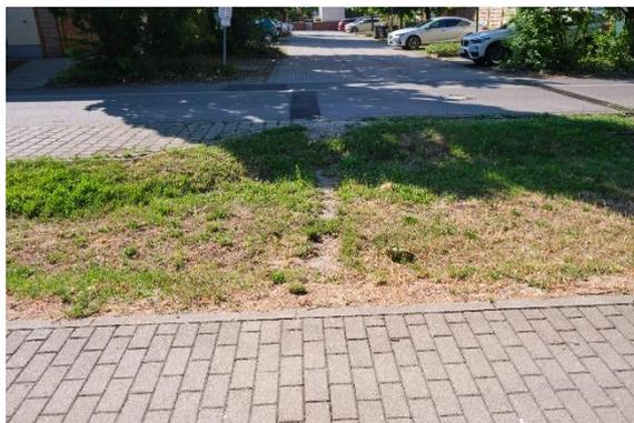
**Abb. 3-43: Zerstörung des Muldenquerschnittes**
