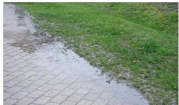
**Abb. 3-45: überhöhte Schulter, diffuse Versickerung**
