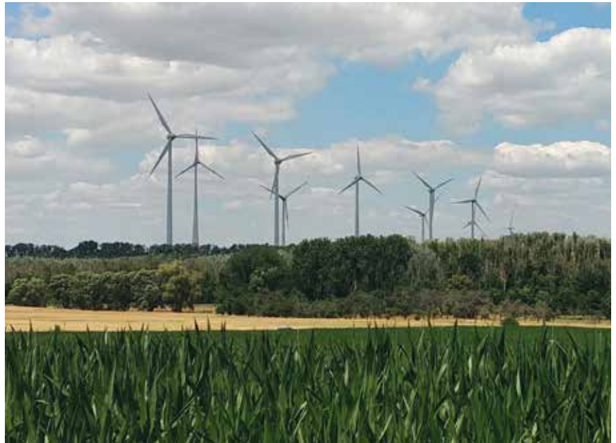
Windenergienutzung in der Bergbaufolgelandschaft bei Hohendorf und Ramsdorf (Stadt Groitzsch bzw. Regis-Breitungen)
