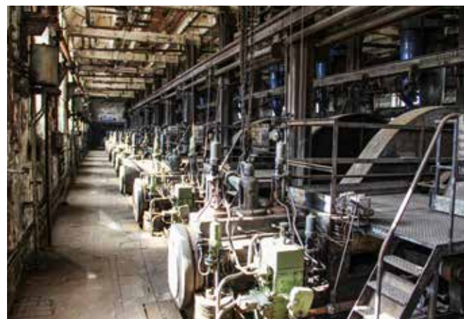
Energiefabrik Knappenrode – Pressenraum
