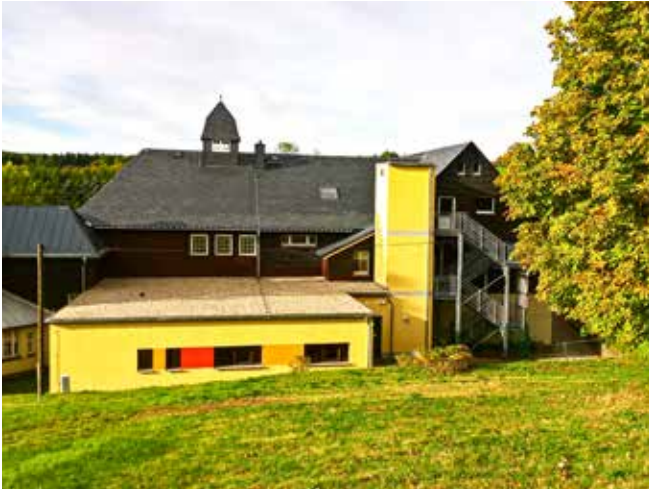
Multifunktionsanbau der Grundschule
