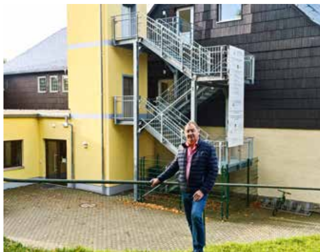
Bürgermeister Andreas Liebscher vor dem neuen Multifunktionsanbau der Grundschule
