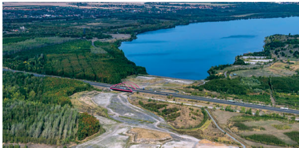
Eine neue Landschaft entsteht – Bau des Harthkanals zwischen Zwenkauer und Cospudener See
