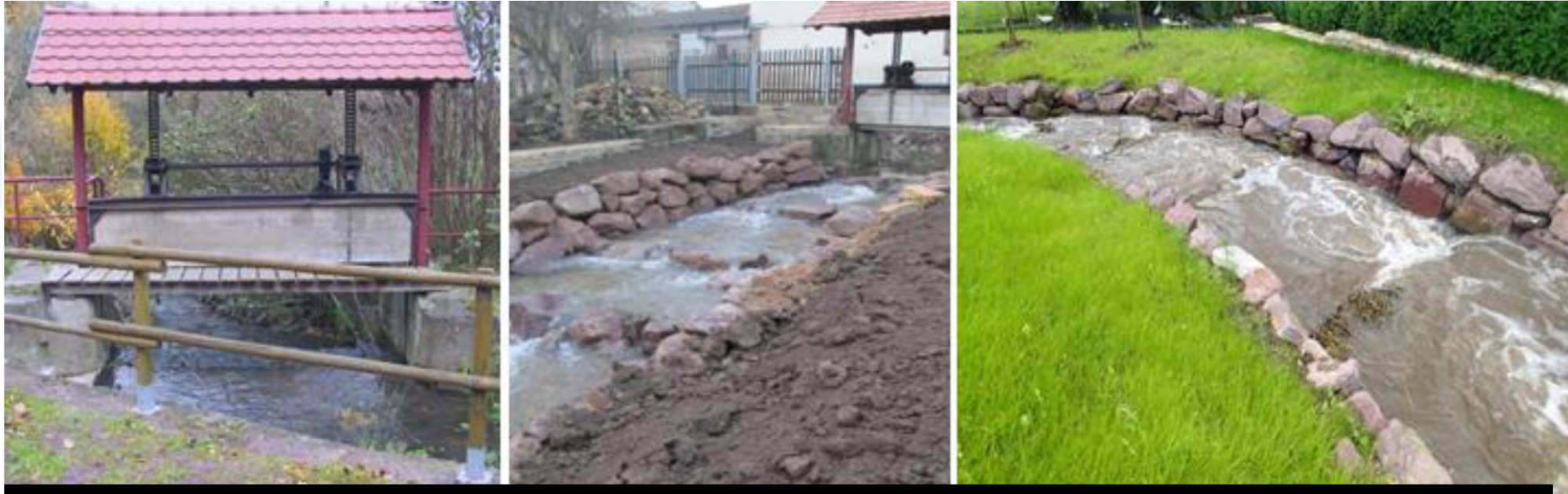
Links: Wehr Zappendorf vor dem Umbau
