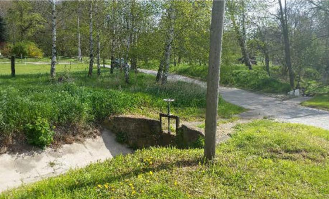
Links: Durchlass Elbitz vor dem Umbau
