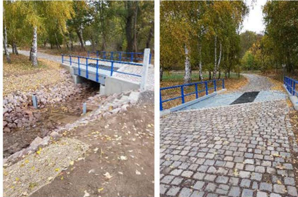
Mitte und Rechts: Brücke nach dem Umbau 10/ 2018
