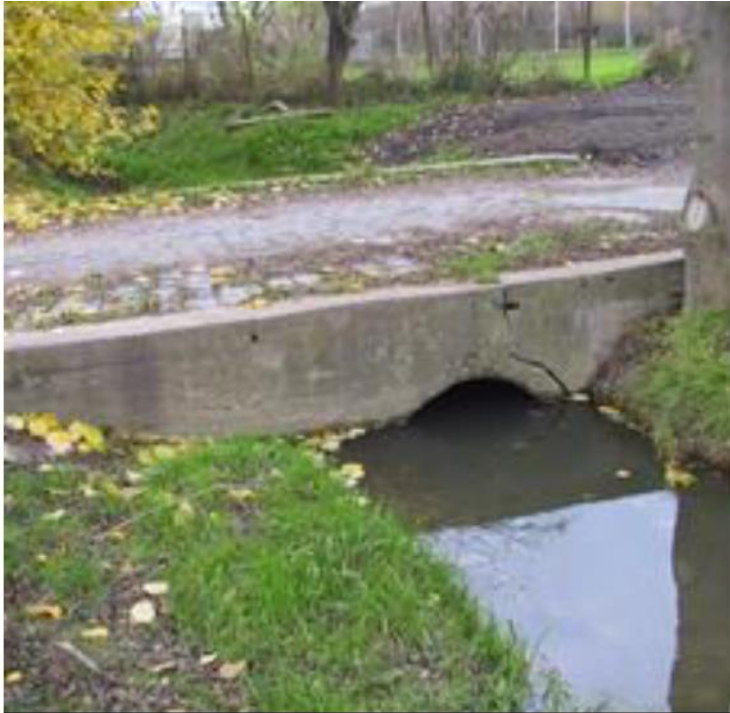
Links: Durchlass Luppühle vor dem Umbau
