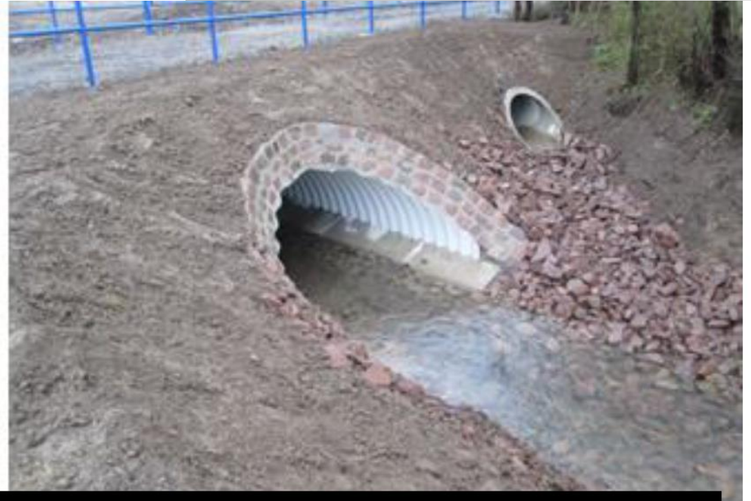
Rechts: Ansicht Durchlass Luppühle, Wellstahlprofil, 01/ 2013
