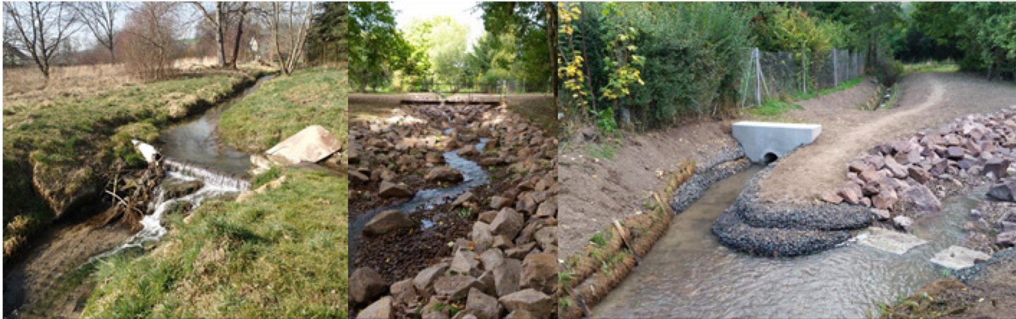
Links: Sperrbauwerk vor dem Umbau
