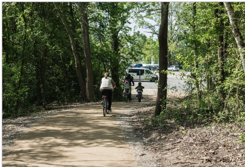
Abbildung 7: Ausgebauter Radweg im Pappelwald. Blick auf das südliche Ende am Parkplatz am Lausener Weg (Foto: team red)
