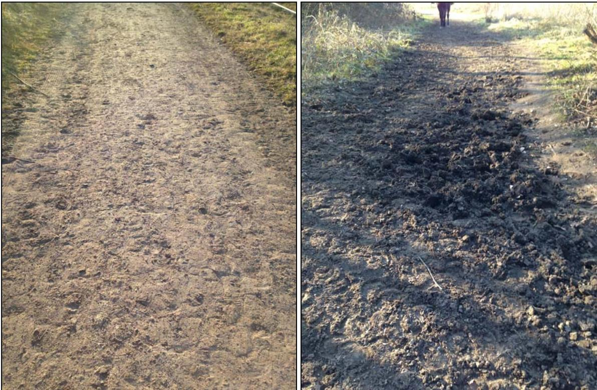
Abbildung 102: Wassergebundene Decke und offener Boden unter hohem Nutzungsdruck, Schadensbild
